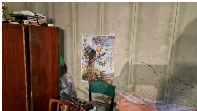
FIGURA 23 – DEGRADĂRI: FISURI PREZENTE ÎN PEREȚI (PREPONDERENT CEI DE COMPARTIMENTARE)
