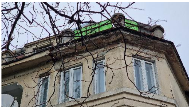
FIGURA 16 – DEGRADĂRI TENCUIELI EXTERIOARE CALCAN (NORD-VEST)
