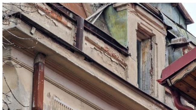
FIGURA 18 – VEDERI GENERALE EXTERIOARE ȘI DEGRADĂRI STREȘINI ȘI CORNIȘE
