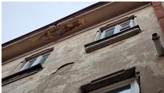
FIGURA 18 – VEDERI GENERALE EXTERIOARE ȘI DEGRADĂRI STREȘINI ȘI CORNIȘE
