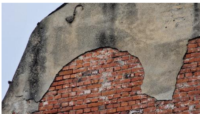
FIGURA 16 – DEGRADĂRI TENCUIELI EXTERIOARE CALCAN (NORD-VEST)
