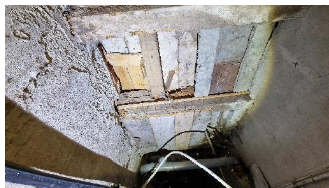
FIGURA 21 – STAREA TEHNICĂ A PLANȘULUI DE LEMN DE PESTE SUBSOL
