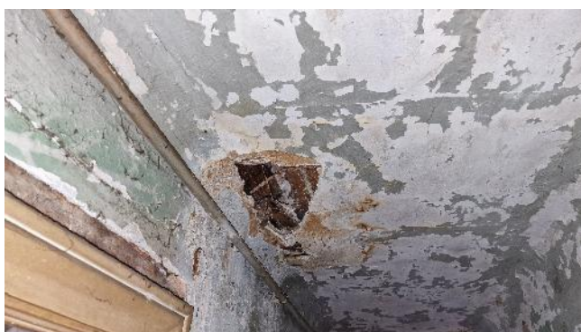
FIGURA 24 – DEGRADĂRI: FISURI PREZENTE ÎN PEREȚI (PREPONDERENT DE COMPARTIMENTARE), BUIANDRUGI ȘI PLANȘEE
