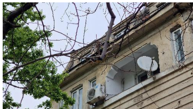
FIGURA 16 – DEGRADĂRI TENCUIELI EXTERIOARE CALCAN (NORD-VEST)
