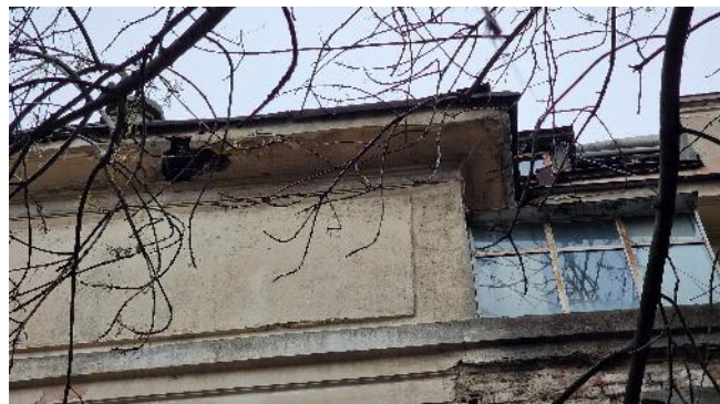
FIGURA 18 – VEDERI GENERALE EXTERIOARE ȘI DEGRADĂRI STREȘINI ȘI CORNIȘE
