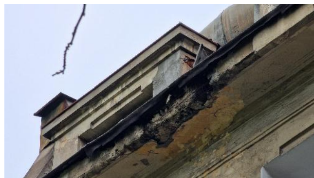
FIGURA 17 – VEDERI GENERALE EXTERIOARE ȘI DEGRADĂRI STREȘINI ȘI CORNIȘE
