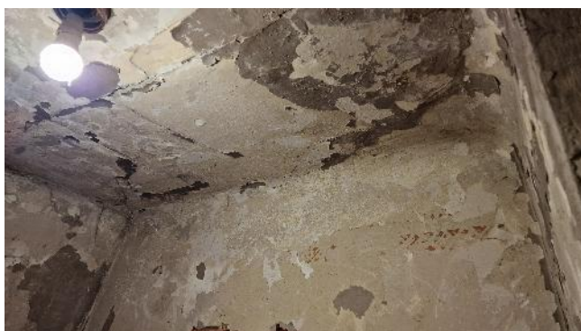
FIGURA 25 – DEGRADĂRI: FISURI PREZENTE ÎN PEREȚI (PREPONDERENT DE COMPARTIMENTARE), BUIANDRUGI ȘI PLANȘEE
