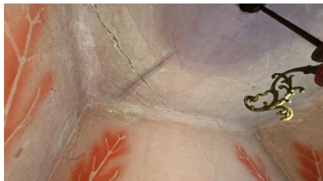
FIGURA 26 – DEGRADĂRI: FISURI PREZENTE ÎN PEREȚI (PREPONDERENT DE COMPARTIMENTARE), BUIANDRUGI ȘI PLANȘEE
