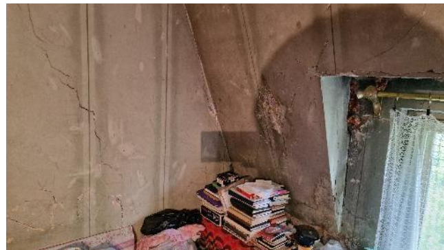
FIGURA 24 – DEGRADĂRI: FISURI PREZENTE ÎN PEREȚI (PREPONDERENT DE COMPARTIMENTARE), BUIANDRUGI ȘI PLANȘEE
