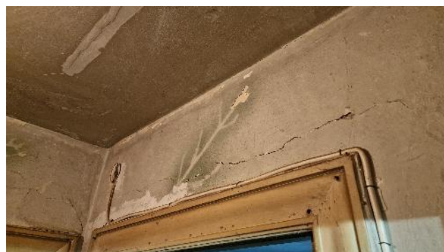
FIGURA 25 – DEGRADĂRI: FISURI PREZENTE ÎN PEREȚI (PREPONDERENT DE COMPARTIMENTARE), BUIANDRUGI ȘI PLANȘEE
