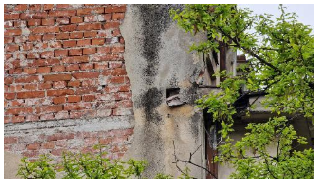
FIGURA 16 – DEGRADĂRI TENCUIELI EXTERIOARE CALCAN (NORD-VEST)
