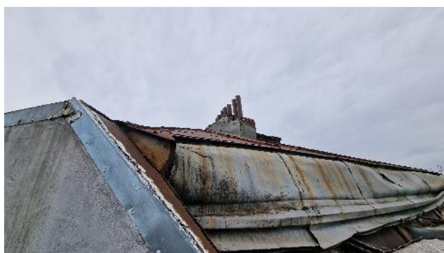
FIGURA 28 – STAREA TEHNICĂ A ÎNVELITORII DIN TABLĂ A ACOPERIȘULUI
