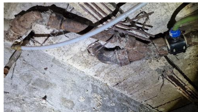
FIGURA 22 – STAREA TEHNICĂ A PLANȘULUI DIN BETON DE PESTE SUBSOL
