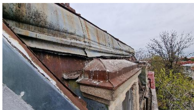
FIGURA 28 – STAREA TEHNICĂ A ÎNVELITORII DIN TABLĂ A ACOPERIȘULUI
