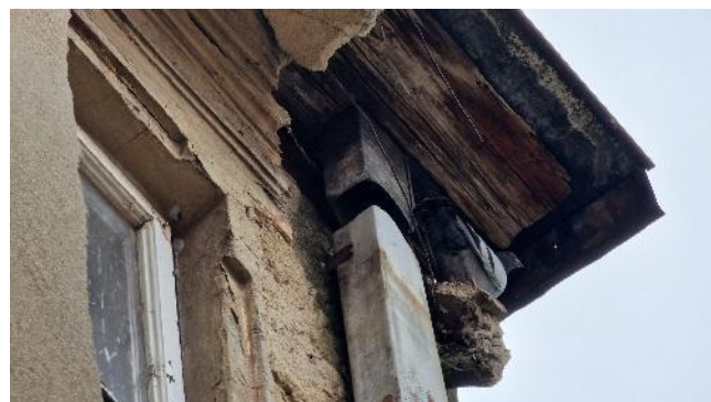
FIGURA 20 – DEGRADĂRI ALE SISTEMULUI DE PRELUARE A APELOR METEORICE DE PE ACOPERIȘ
