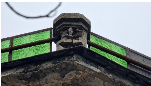
FIGURA 17 – VEDERI GENERALE EXTERIOARE ȘI DEGRADĂRI STREȘINI ȘI CORNIȘE
