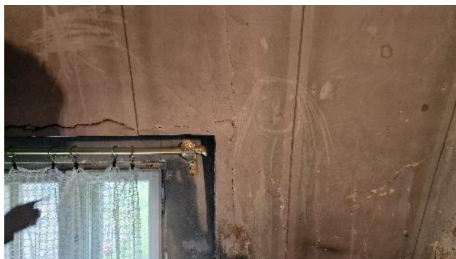
FIGURA 23 – DEGRADĂRI: FISURI PREZENTE ÎN PEREȚI (PREPONDERENT CEI DE COMPARTIMENTARE)
