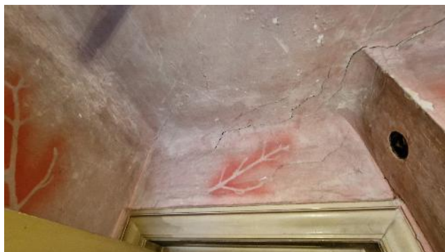
FIGURA 26 – DEGRADĂRI: FISURI PREZENTE ÎN PEREȚI (PREPONDERENT DE COMPARTIMENTARE), BUIANDRUGI ȘI PLANȘEE
