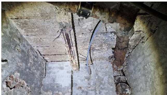
FIGURA 21 – STAREA TEHNICĂ A PLANȘULUI DE LEMN DE PESTE SUBSOL
