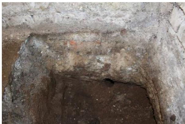
FIGURA 5 – SONDAJE DESCHISE FUNDAȚII
