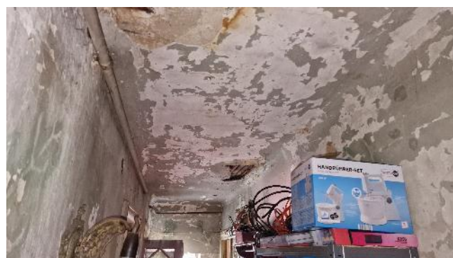
FIGURA 24 – DEGRADĂRI: FISURI PREZENTE ÎN PEREȚI (PREPONDERENT DE COMPARTIMENTARE), BUIANDRUGI ȘI PLANȘEE
