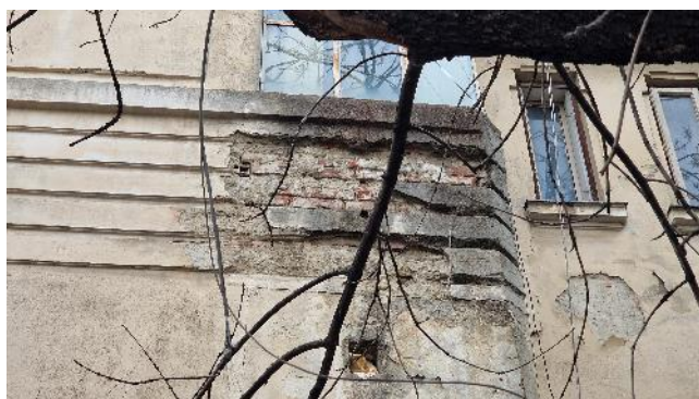
FIGURA 18 – VEDERI GENERALE EXTERIOARE ȘI DEGRADĂRI STREȘINI ȘI CORNIȘE
